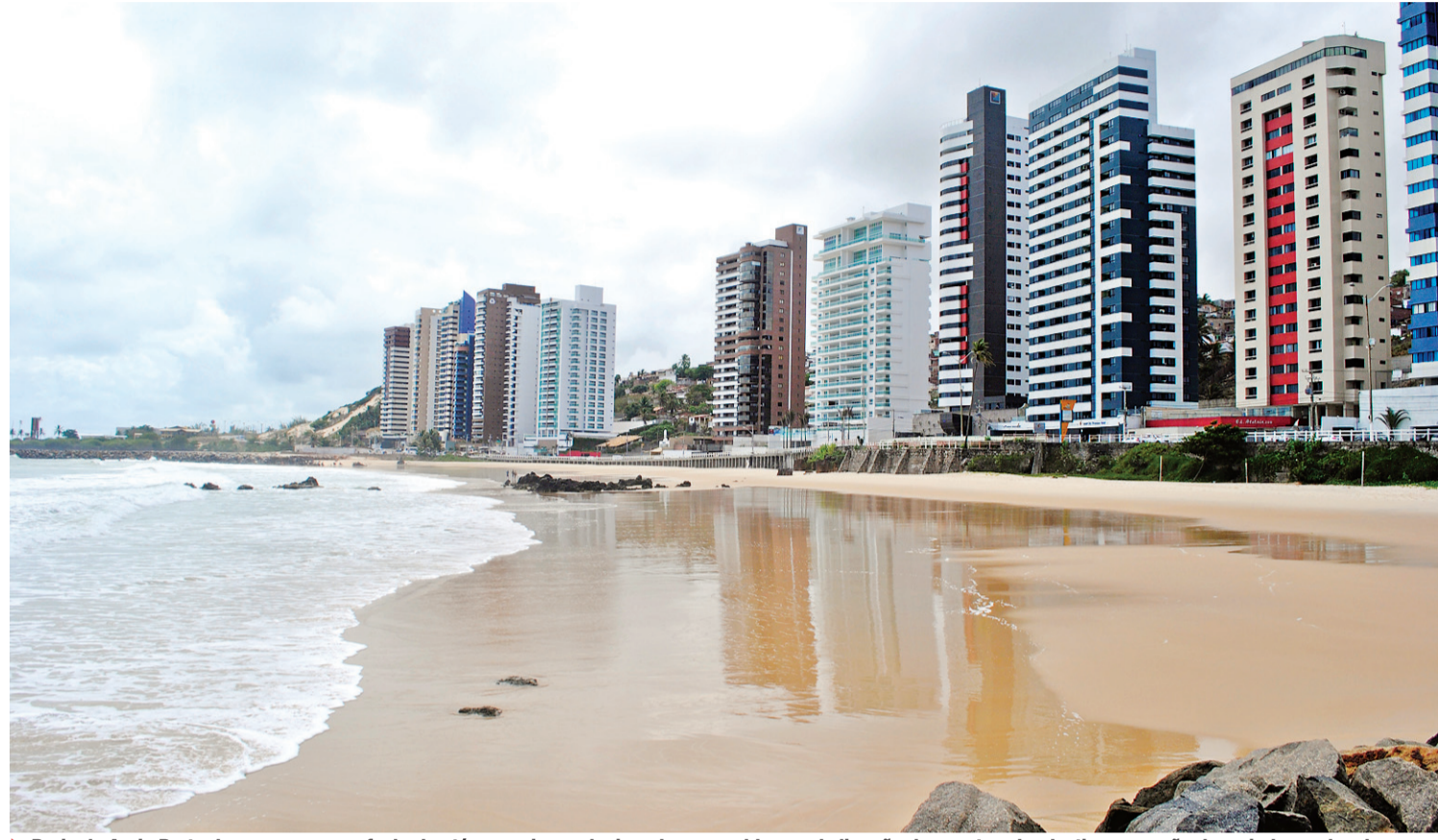
► Praia de Areia Preta deve permanecer fechada até que sejam solucionados os problemas de ligação de esgotos clandestinos que são despejados no local
