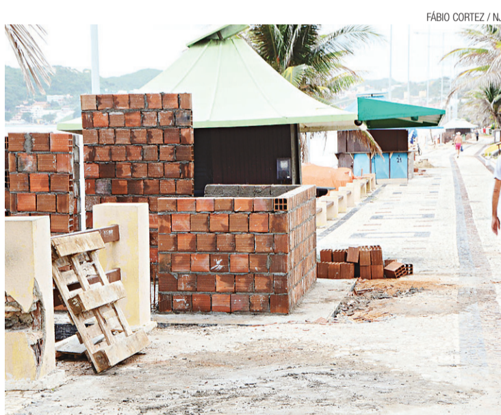
► Reforma do calçamento está em execução
