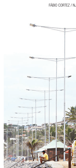
► Nova iluminação na praia
