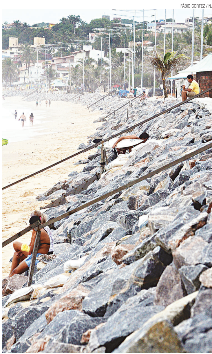
► Obra paralisada desde janeiro contabiliza 95% de execução
