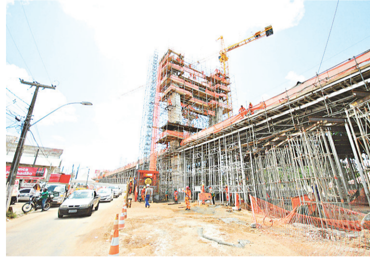
▶ Pavimentação de pistas do viaduto estaiado fecha Prudente durante 15 dias
