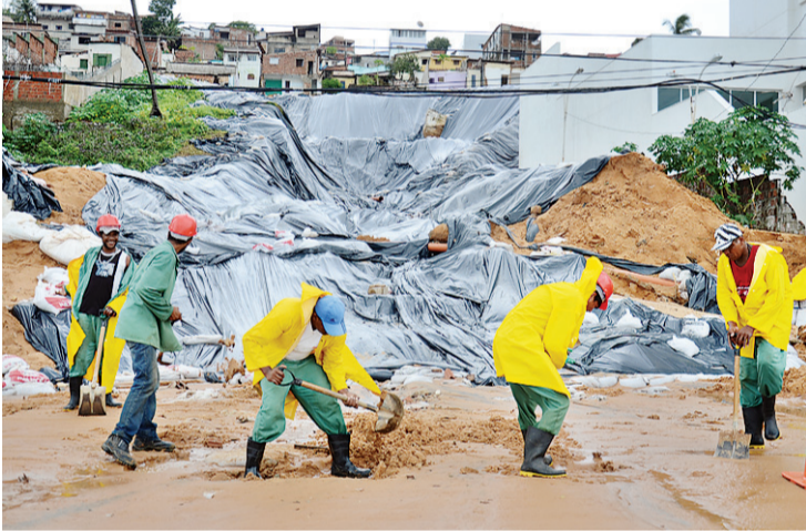
► Lonas ainda cobrem o terreno na tentativa de impermeabilizar o solo
