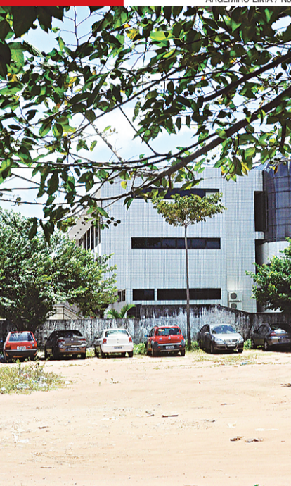
► Em troca, MP terá de construir praça
