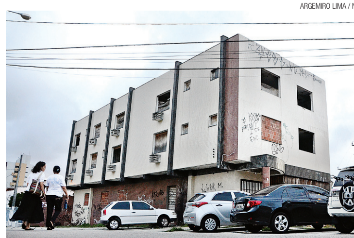
► Demolição do edifício está orçada em R$ 100 mil
