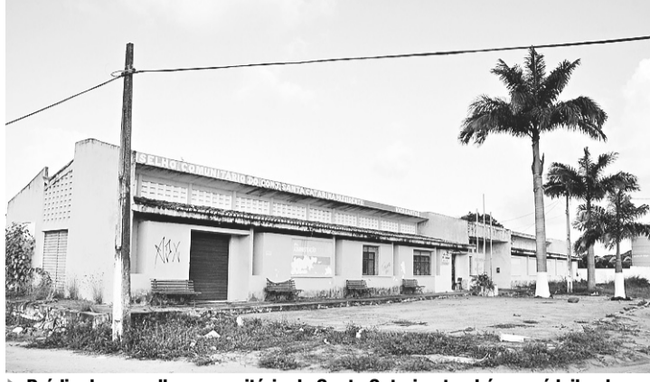
Prédio do conselho comunitário do Santa Catarina também será leiloado
