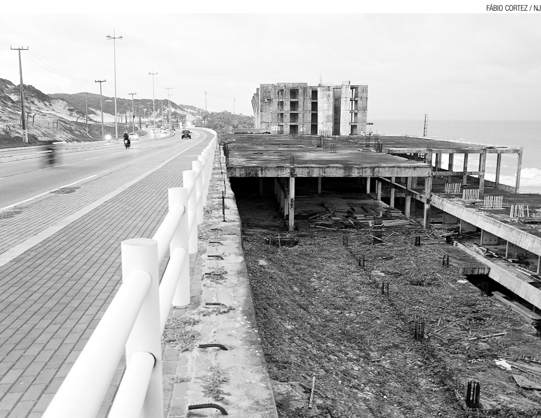
► Construção foi embargada em 2006 e desde então as ruínas do que seria o prédio permanecem poluindo a vista
