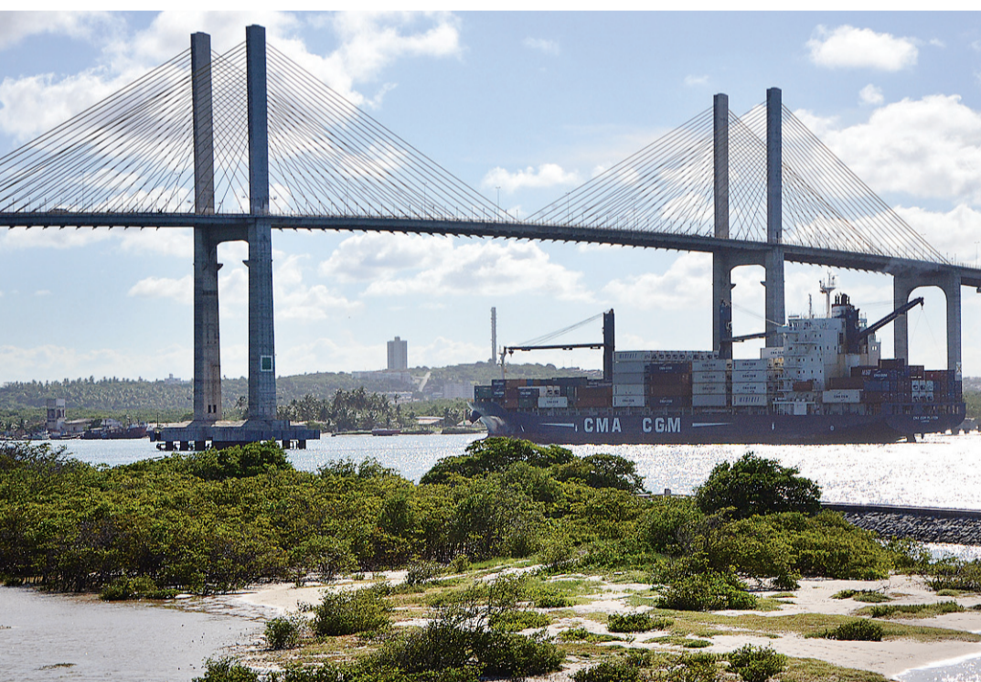
► Defensas para a ponte Newton Navarro também estão previstas pela Codern
