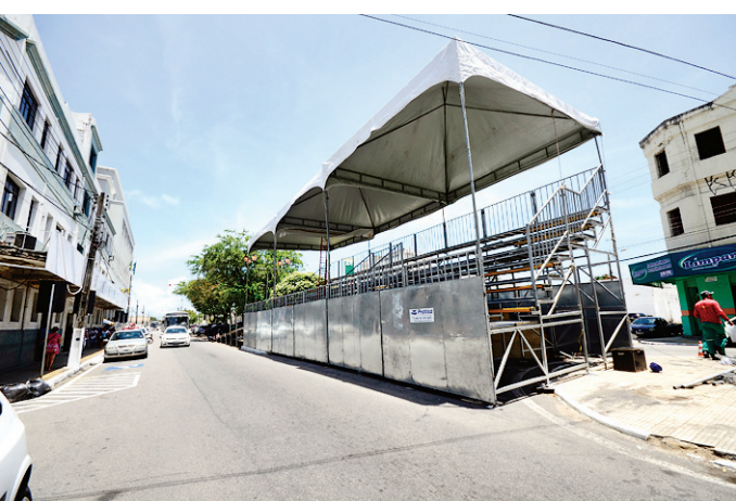
► Na Avenida Duque da Caxias, Ribeira, arquibancadas sendo montadas
