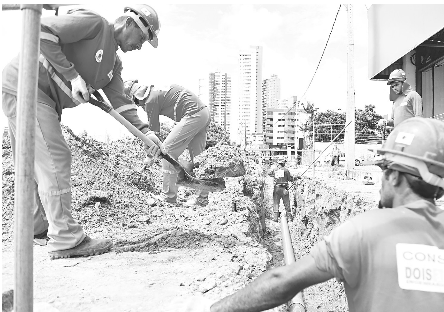
// Quase 240 km de tubulações já foram implantadas em vários pontos da capital, como no trecho da avenida Prudente de Moraes, em Lagoa Nova
