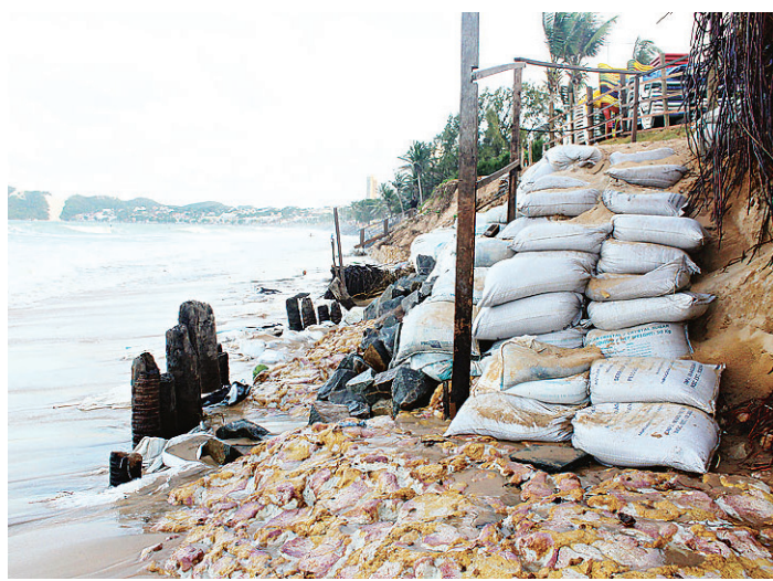
// Parte do calçadão foi destruído pela maré alta no final de semana
