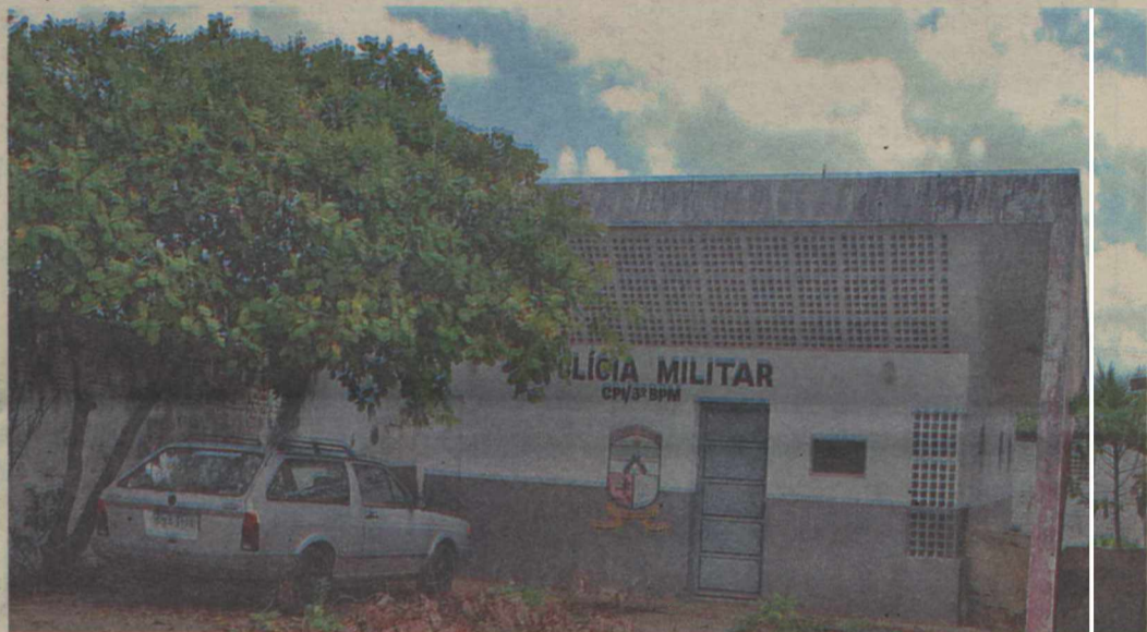
Prédio que deveria servir para garantir a segurança no bairro está entregue a usuários de tóxicos e marginais
