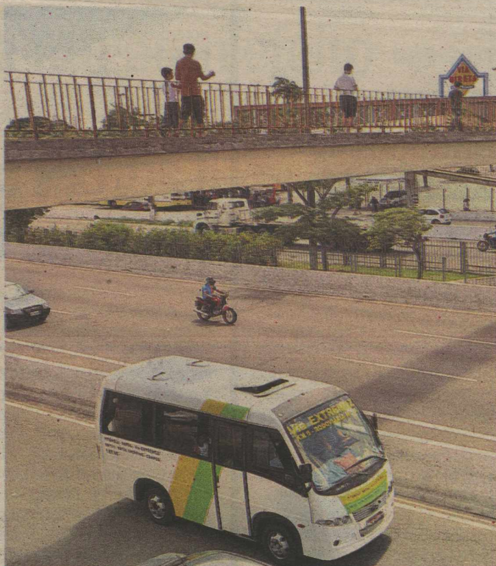
Estruturas que ficam sobre a BR-101 devem ser as primeiras restauradas
