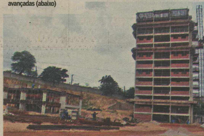
Acima, maquete virtual do Paradise Village, com obras avançadas (abaixo)
