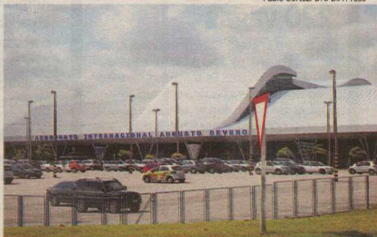
Obras deverão começar ainda este trimestre, com duração de dez meses
