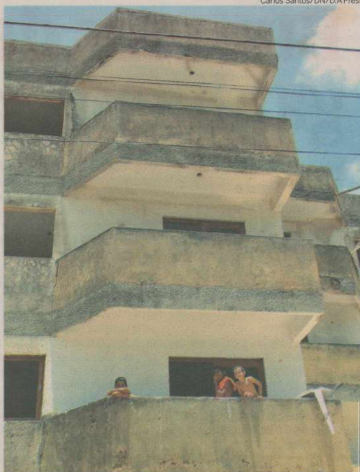
Edifício na Antônio Basílio teve obras paralisadas e foi ocupado por 12 pessoas
