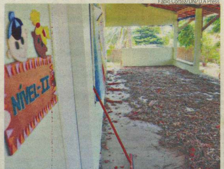
No Centro Municipal Galdina Guimarães, obras contam com três funcionários
