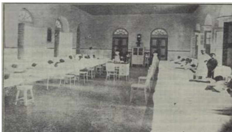
Fig. 20 - Enfermaria São José Hospital Santo Amaro. Fonte: BODAS de ouro das Filhas de Sant’Ana, 1934, p. 63.
