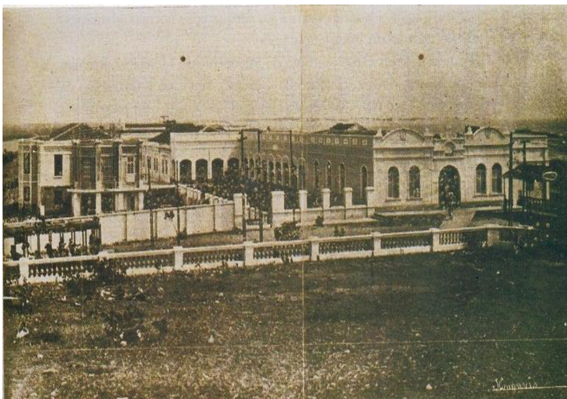
Fig. 11 - Vista geral do HCJB.
