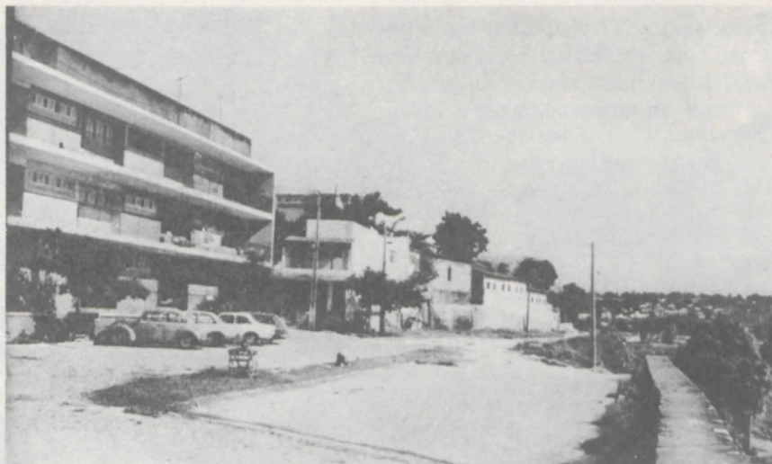
Av. de Contorno desafogará o tráfego vindo da Ribeira
