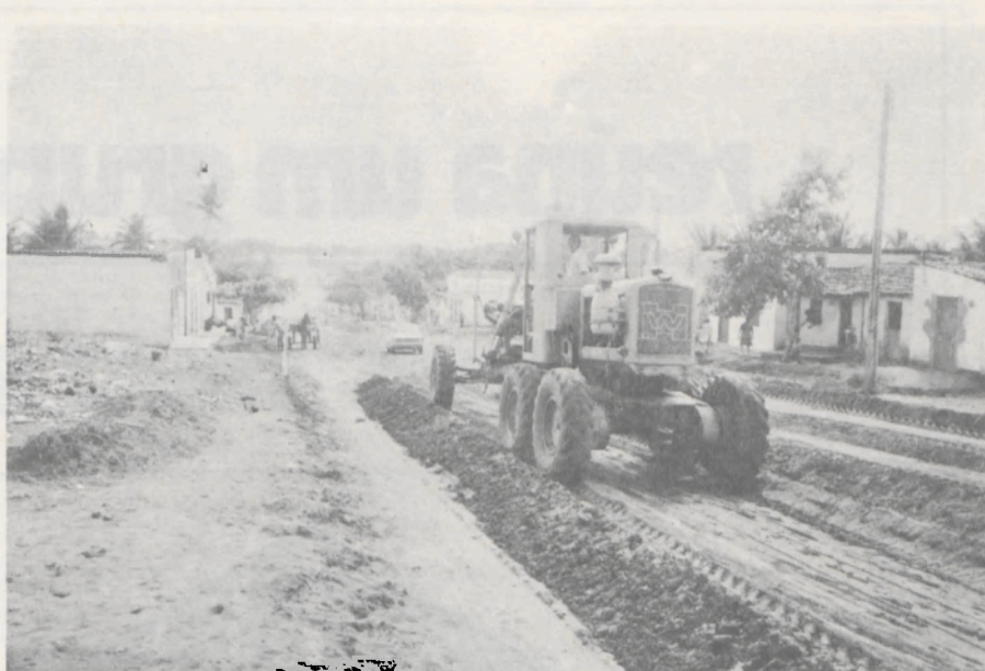
Nivelamento da rua Coronel Estevam
