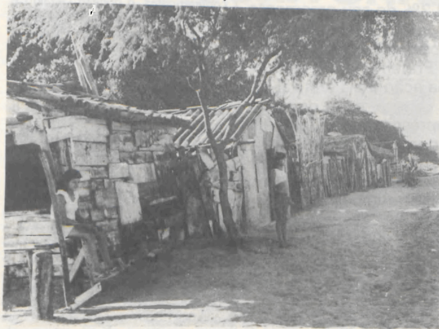
Favela dos Tororós, próxima ao Castelão
