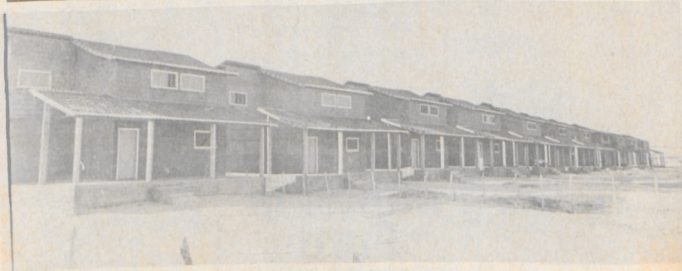
Vista parcial da Nova Redinha, um empreendimento vitorioso.
